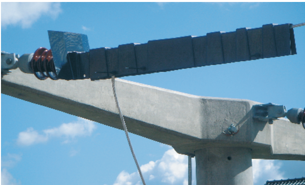
Abb. 8: Für Nachrüstung: Abdeckungen für Seilklemmen an Abspannmasten sind eine wirksame Vogelschutzmaßnahme. Abdeckungen sind auch für doppelte Isolatoren möglich.
