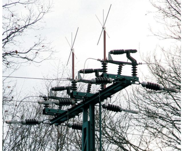
Abb. 7: Masten mit Schalter auf dem Mastkopf dürfen nicht mehr errichtet werden. Bei alten Masten dieses Typs sind Andreskreuze (hier im Mastschalter) zulässig.
