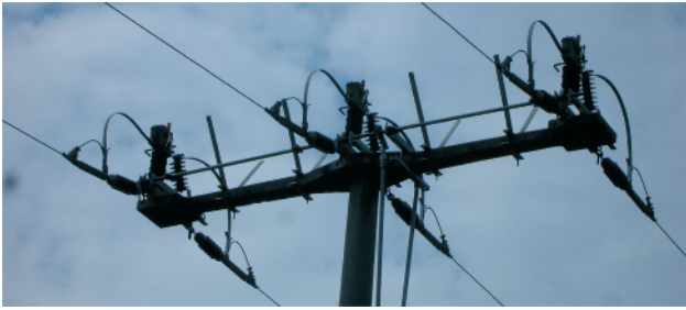
Abb. 4: Untauglich: V-förmige Vogelabweiser (hier zwischen den Schalterelementen)
