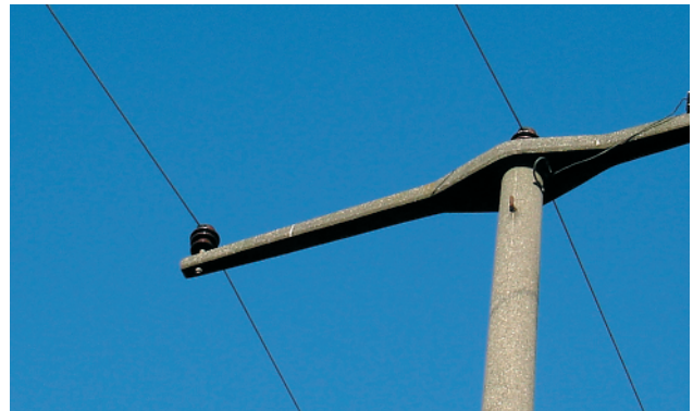
Abb. 9: Bei Neubau: Stehende Isolatoren sind auf leitfähigen Masten (Stahl oder Beton mit nicht isolierter Traverse) unzulässig.
