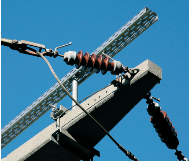
Abb. 6: Untauglich: Sitzprofil mit leitfähiger Befestigung
