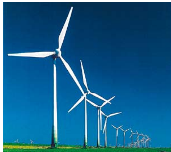
Windpark Friedrich Wilhelm Lübke-Koog vor dem Repowering
