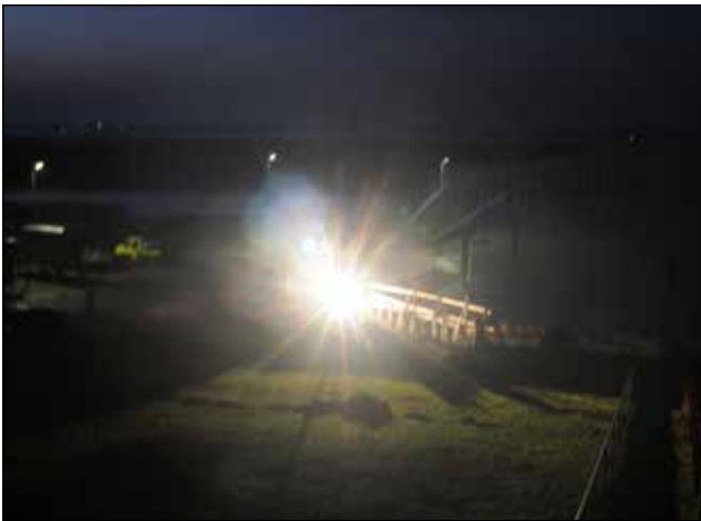
Baustellenbeleuchtung am Siel 13.12.2013
