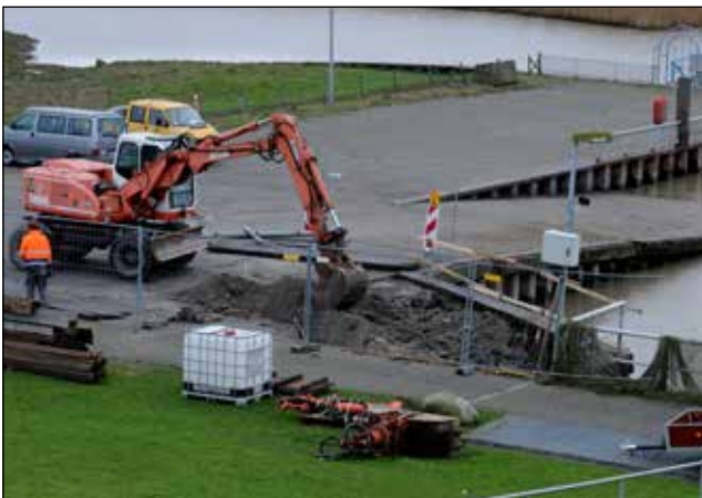
Baggararbeiten an Siel-Spundwand 28.11.2013
