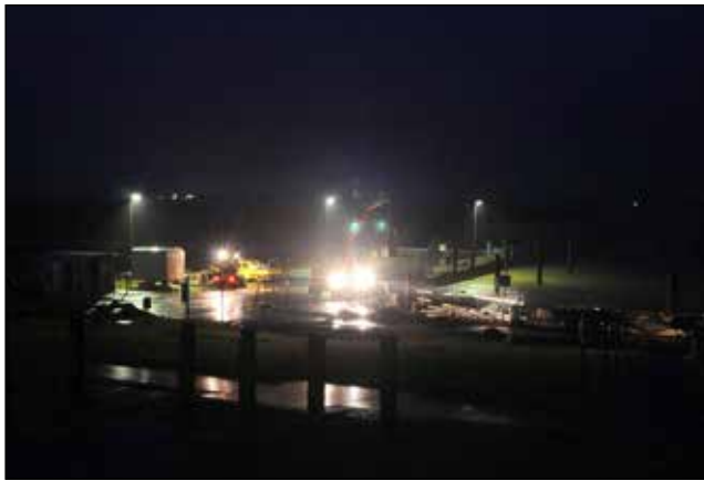
Bauarbeiten am Petkumer Siel 09.01.2014
