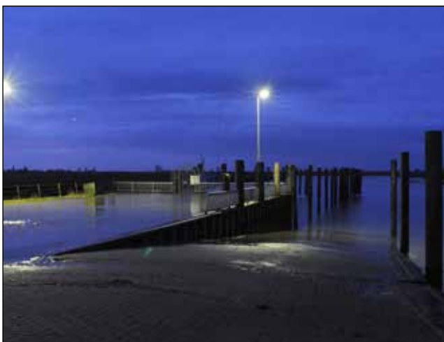
Verschammung von Fähranleger nach Überflutung, 07.12.2013
