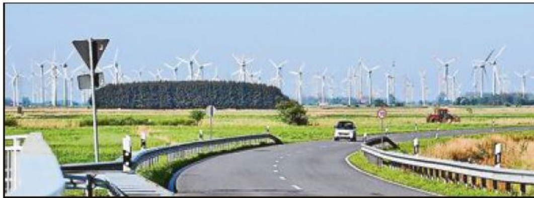
Der Windpark Utgast - von der Umgehungsstraße Bensorsiel aus gesehen.
