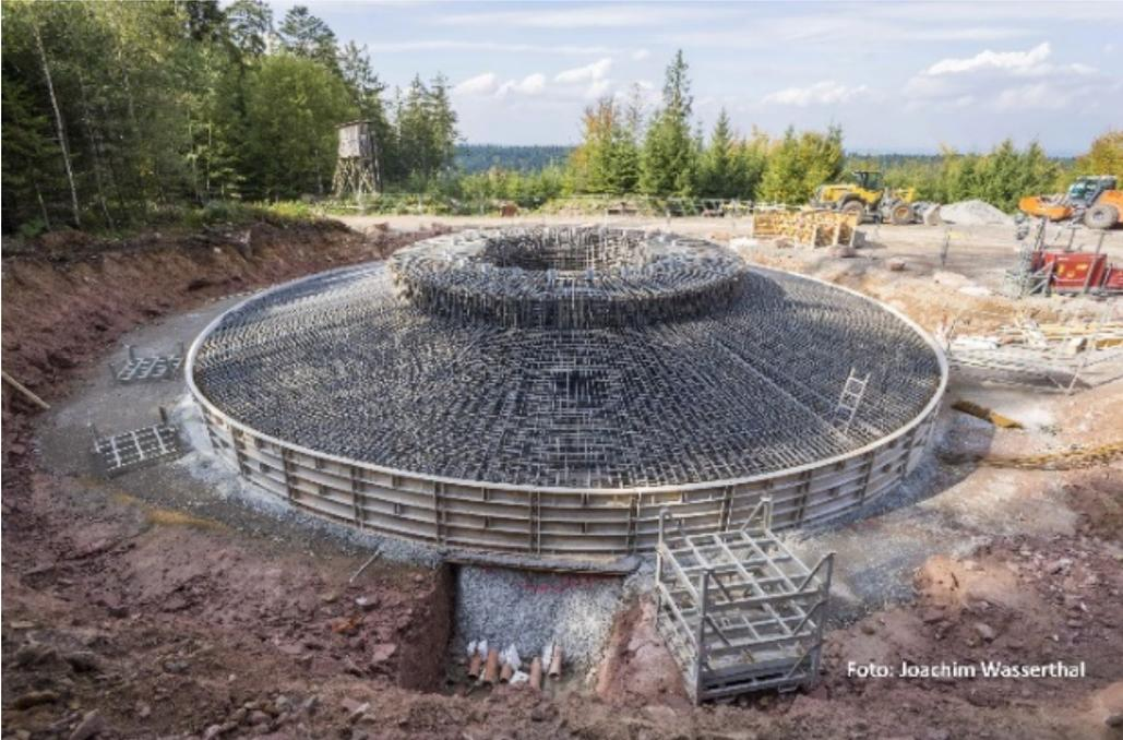
Abbildung 43: riesiges Betonfundament für ein Windrad
