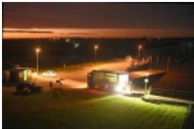
Rückbau von Fischimbiss
